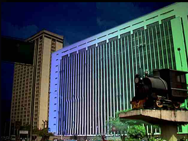
ILUMINACIÓN CON PROYECTORES / FACHADA LA ALPUJARRA
